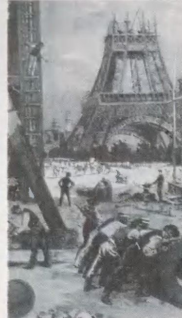
Строительство Эйфелевой башни
